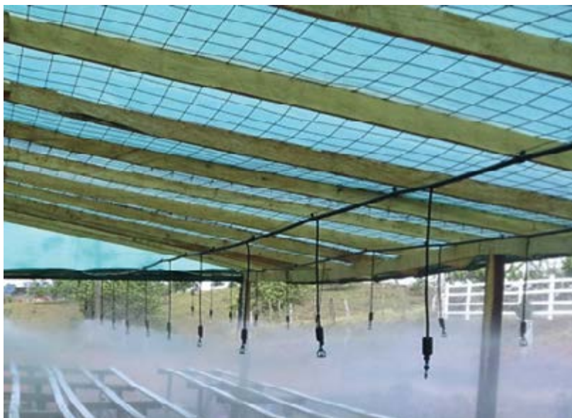
Figura 5. Malla de alambre colocada en el techo para sostener la lámina de plástico y evitar la formación de bolsas de agua.
