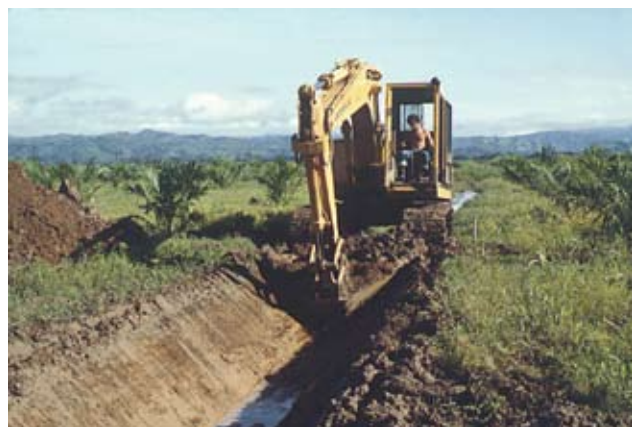
Construcción de canal de drenaje
